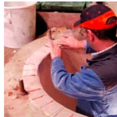
Vor dem Einsetzen des Dorit-Fertigtiegels werden die Isolierungen und das Tiegelbett eingebracht.
