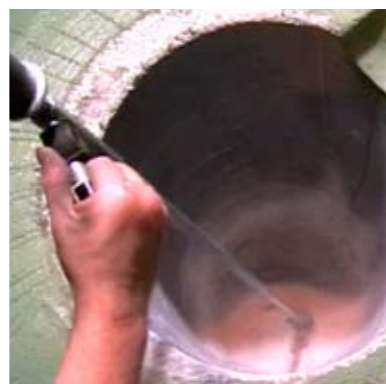
Die Montageöffnung wird mit Bodenlochmasse gefüllt und verdichtet.
